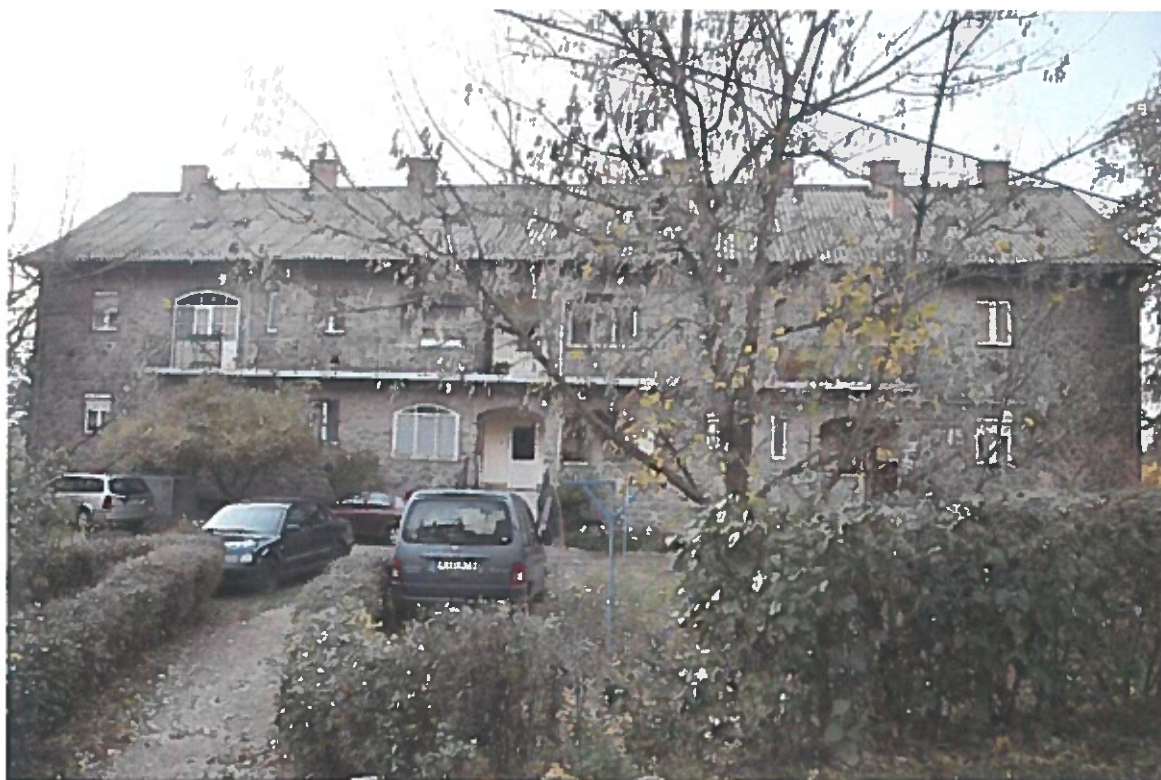
Másik, kapcsolódóan szép földszinti bejárat megoldás
