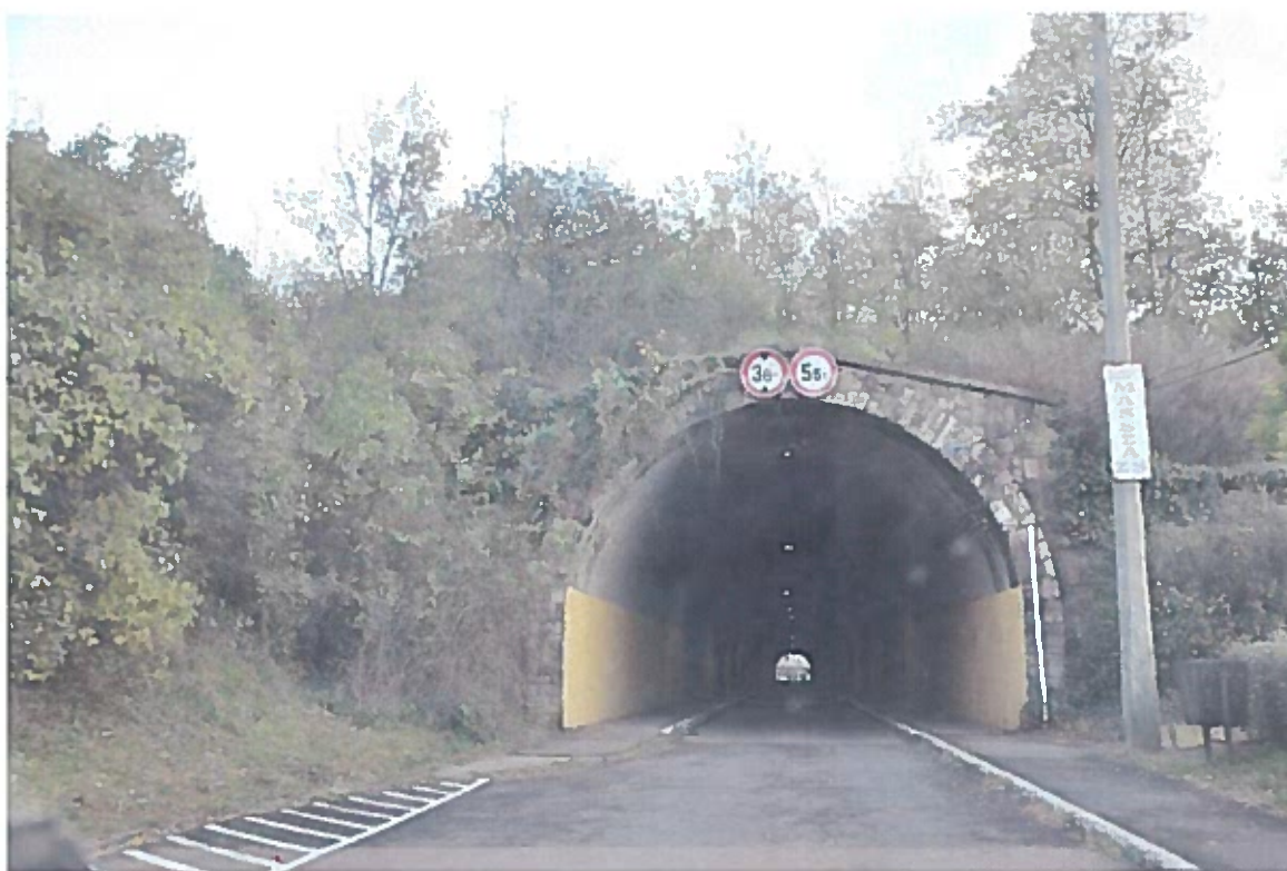
Közüti alagút. Hrsz.: 316
